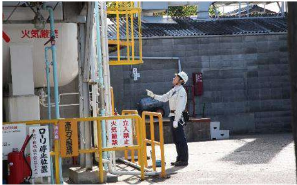
(ガス漏れ発生)
